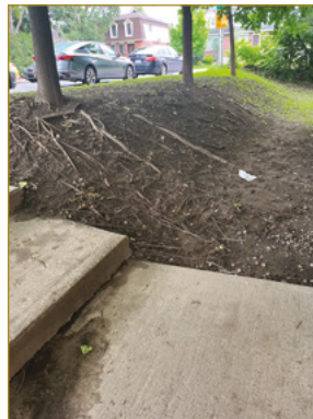
Muret avant et après Nouveau muret à la Place Brazeau
